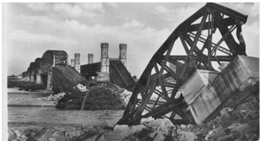
Zniszczone mosty w kampanii wrześniowej 1939 r.
